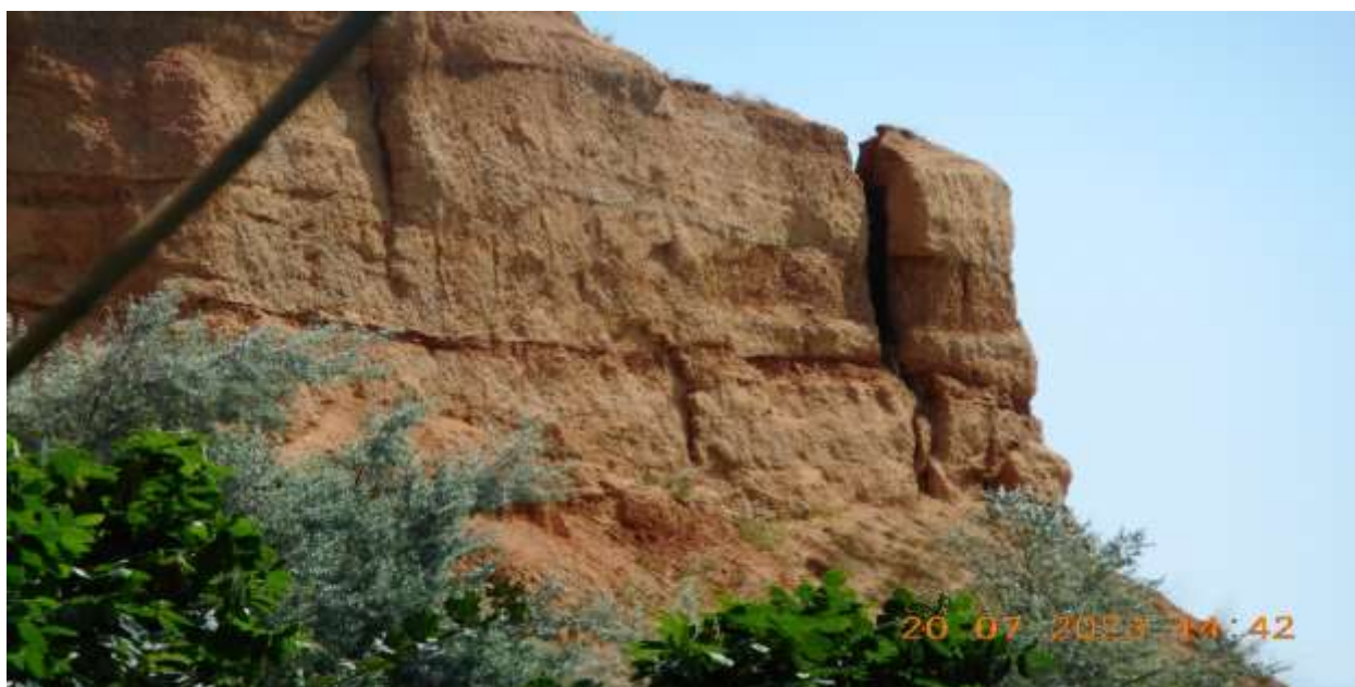
Рис. 2.25 Закол блока, готового к обрушению
