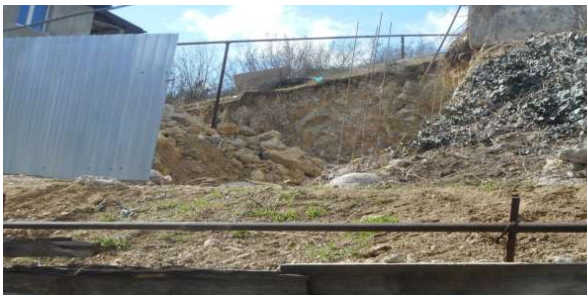
Рис. 2.19 Ведутся земляные работы, складирование грунта
