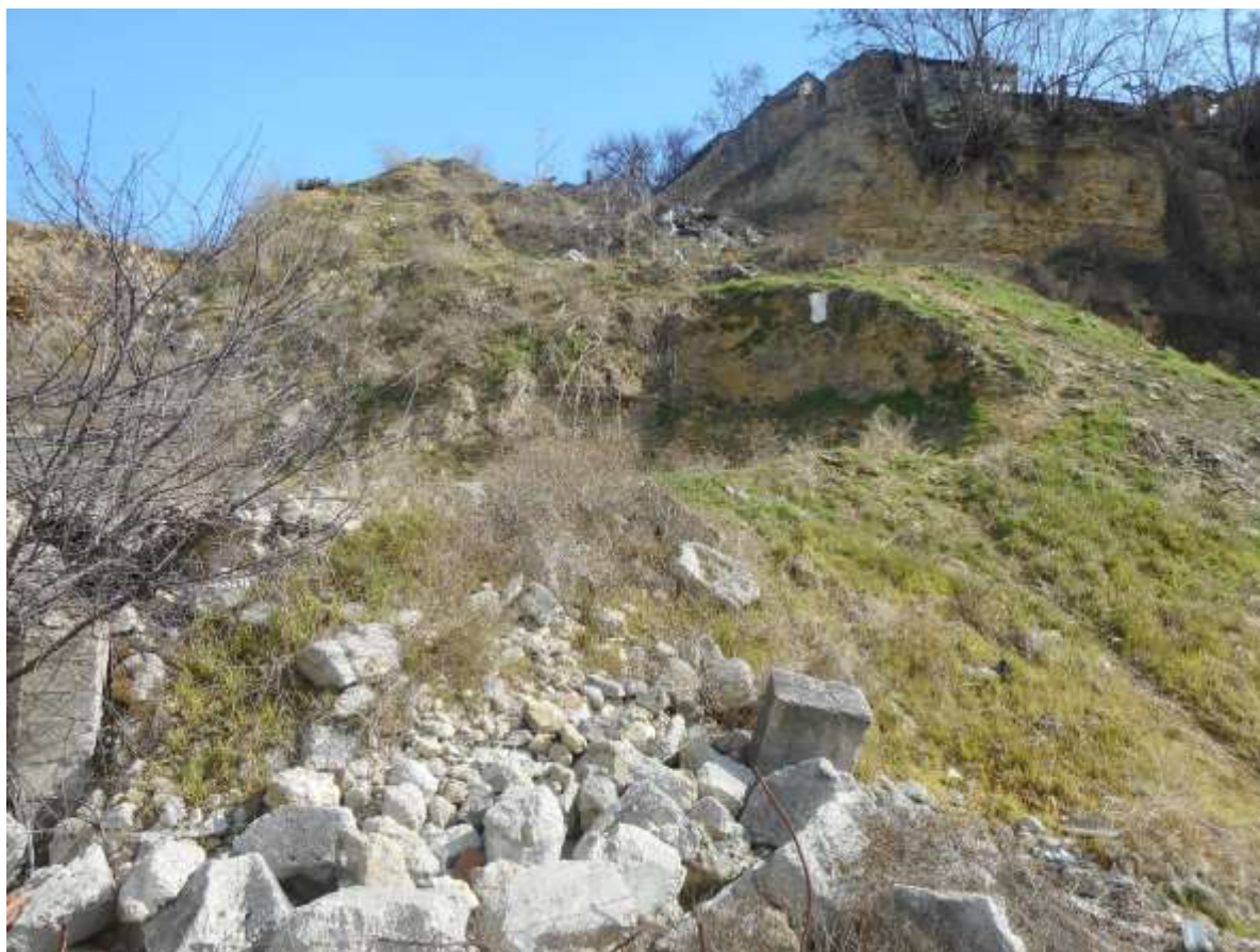
Рис. 2.8 Признаки активизации оползня ПН № 92-11-0004
