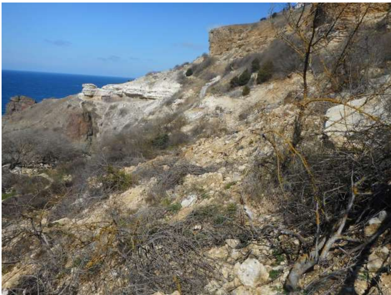
Рис. 2.23 Оползень и осыпи на месте где была тропа к лестнице на пляж «Царское село»
