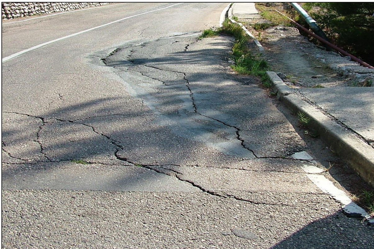
Рис. 2.13. Дорога на Батилиман. Головная часть оползня. Просадка автодороги в верхней правой части оползня. Две свежие трещины растяжения до 5 см в ширину и 1,5 м в длину. I квартал 2021 г. (№ 67-1110-0008)
