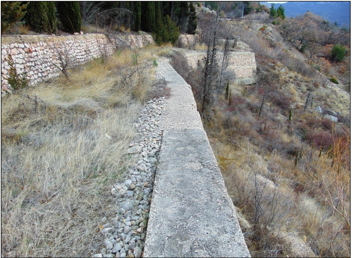
Рис. 2.14. Подпорные стены в головной части оползня. Деформаций нет. II квартал 2021 г. (№ 67-1110-0009)
