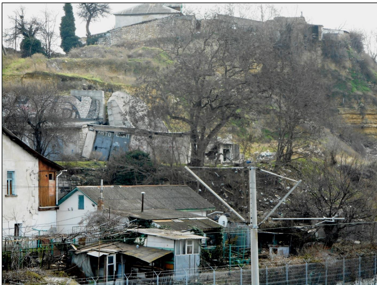
Рис. 2.6. Общий вид оползневого склона «Ул. Тенистая-ж.д.» I квартал 2021г. В правом борту оползня полуразрушенные гаражные боксы и разрушенная подпорная стена. (№ 67-1110-0004)
