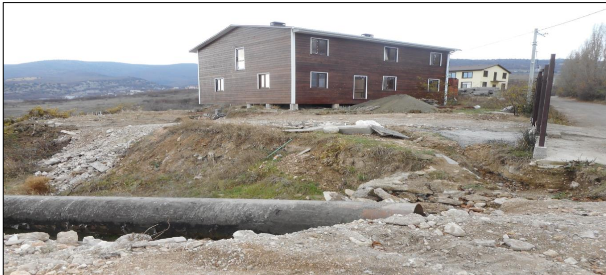
Рис. 2.5. В головном срыве оползня для отвода поверхностных вод с вышележащей улицы положена труба. Высота срыва около 2-х м. IV квартал 2021 г. Основание срыва засыпано строительным мусором. (№ 67-1110-0003)
