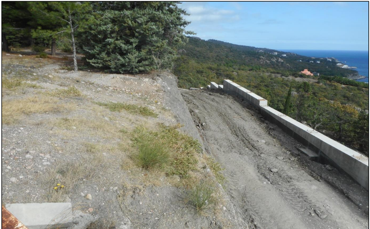
Рис. 2.12. Нижняя часть оползня (ниже автотрассы Севастополь-Ялта). Подрезка склона, строительство дороги и подпорных стен. IV квартал 2021 г. (№ 67-1110-0007)
