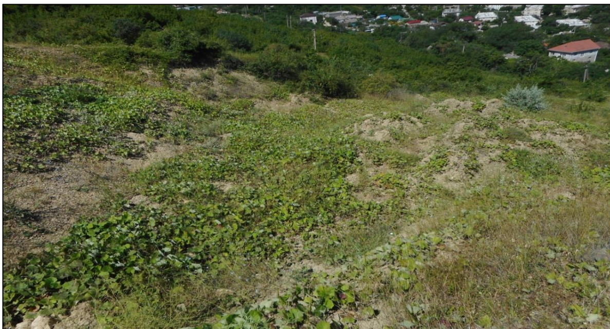
Рис. 2.3. Активная часть оползня № 1652 в форме глетчера. Породы перемяты. Задернован. Высота срывов 1-2 м. I кв. 2021 г. (№ 67-1110-0001)
