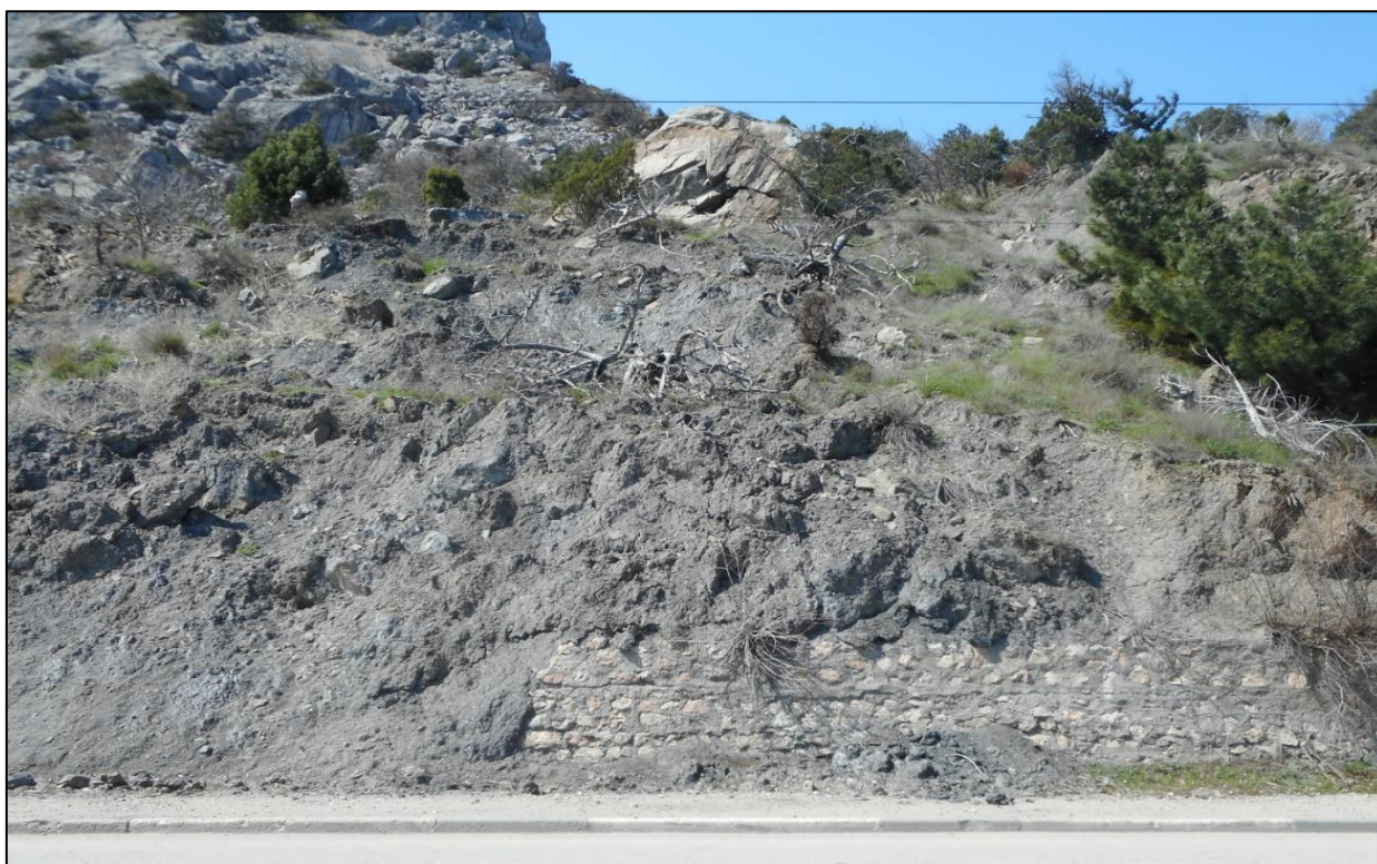
Рис. 2.11. Наползание оползня на подпорную стену и на тротуарную часть автодороги. II квартал 2021 г. (№ 67-1110-0007)
