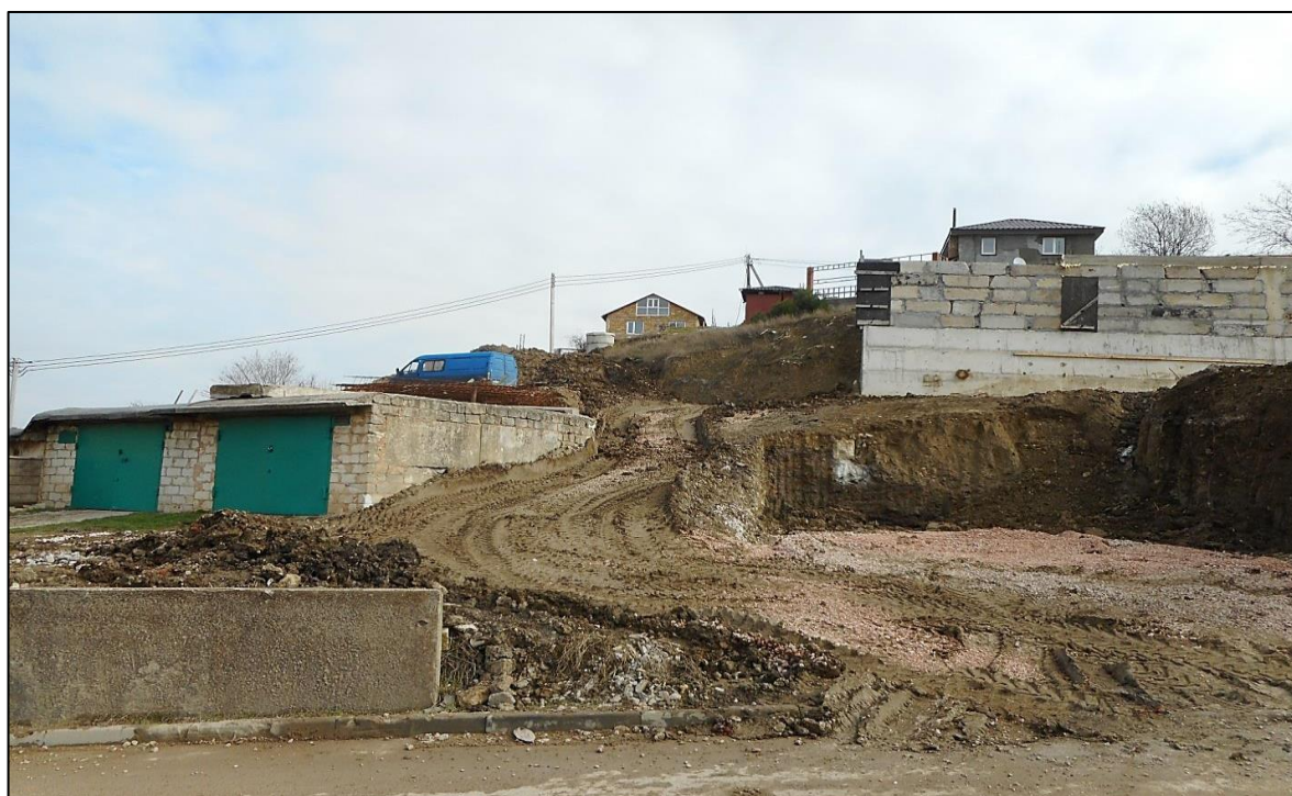
Рис. 2.10. Языковая часть оползня. Строительство капитальных строений и подпорных стен. I квартал 2021 г. (№ 67-1110-0006)
