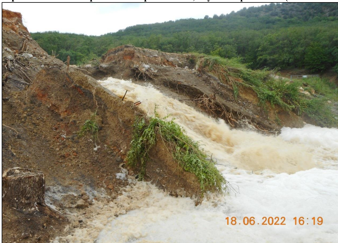
Рис. 2.20. Пруд Лесное озеро. Прорыв земляной плотины с последующим сбросом вод по руслу реки Сухая речка (18.06.2021 г.)
