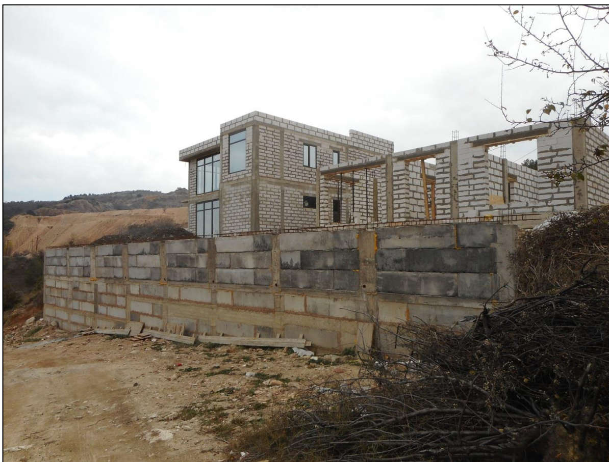
Рис. 2.4. На террасированном оползневом склоне в средней его части ведется строительство зданий и подпорной стены. II квартал 2021 г. (№67-1110-0002)
