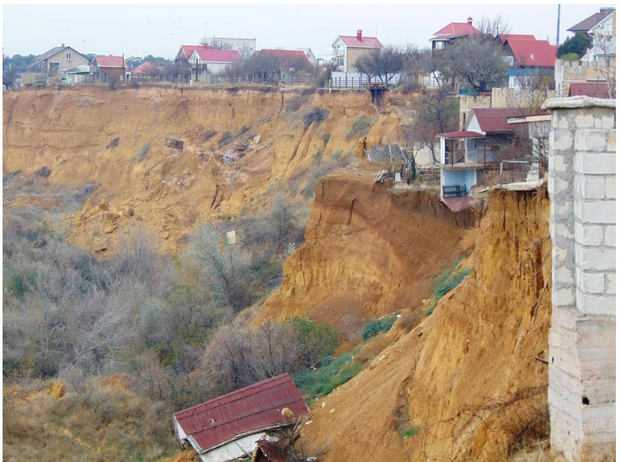
Рис. 2.2.17 Головной срыв и дачи вдоль бровки срыва. IV квартал 2019 г.
