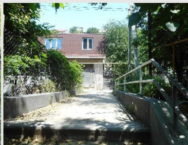
На жилых домах и оградах №№ 19 - 29 по ул. Подольцева свежих деформаций нет. Дома построены на оползне.
