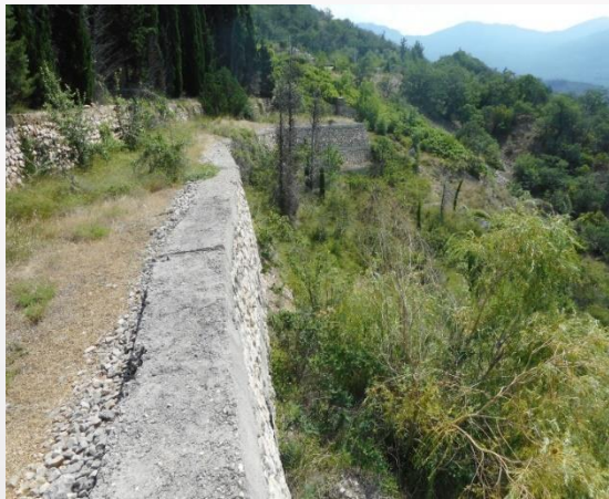
Головной срыв. Подпорная стенка над головным срывом. Деформаций нет.
