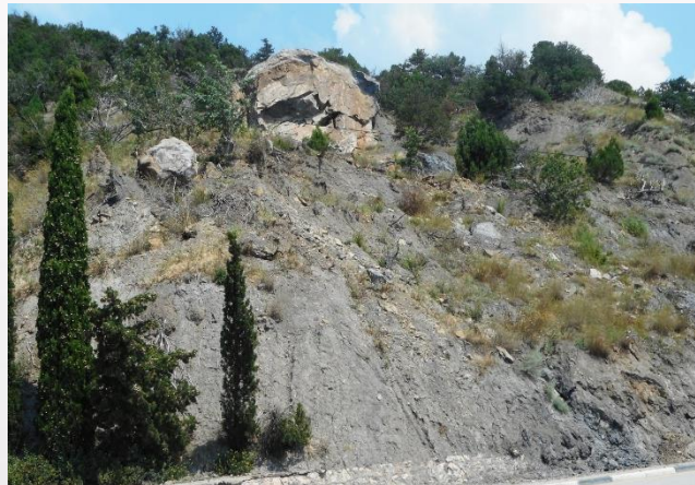
Тело оползня. Оплывины в центральной части тела оползня. Разрушен бетонный слой подпорной стенки. Сползание грунта на подпорную стену.
