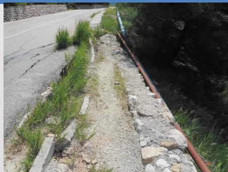
Головная часть оползня. На линии срыва наблюдается растительность характерная для увлажнённых мест.
