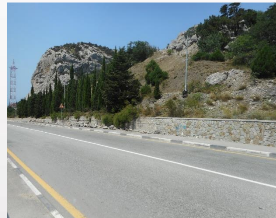
Осыпные процессы на теле оползня. Правая сторона оползня. Стенка срыва. Перемятие грунта. Глыба магматических пород- продукты разрушения дайки.
