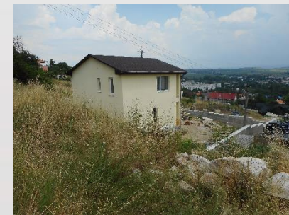
Левый борт оползня.
