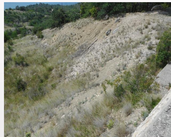
Центральная часть оползня задернована.
