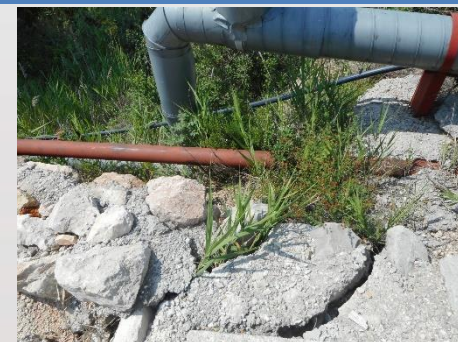
Головная часть оползня. Деформации железобетонных тротуарных плит. Увеличение ширины трещин между тротуаром и бордюром
