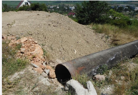
Левый борт оползня. Поверхность оползня задернована. Линия растяжения в техногенных насыпных массах. Линия срыва пригружена валунами и грунтом.
