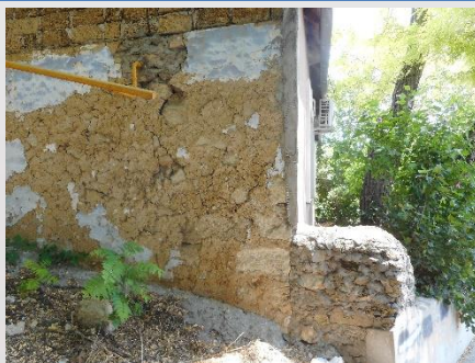
Западная стена дома №5 по ул. Ревякина в левом борту оползня. Свежих деформаций нет
