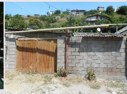
На жилых домах и оградах №№ 19 - 29 по ул. Подольцева свежих деформаций нет. Дома построены на оползне.
