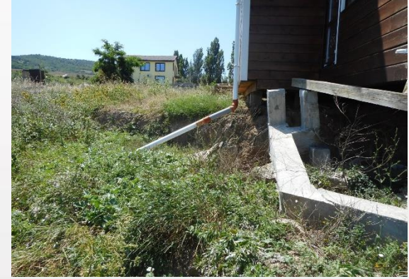
Головной срыв. Новых деформаций нет. Небольшие осыпные процессы на стенке головного срыва
