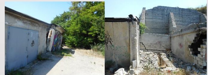
Правый борт оползня. Полуразрушенный гараж. Деформация подпорной стенки, осыпавшийся грунт из- за подпорной стены. Трещины в подпорной стене, полуразрушенная гаражная стена. Деформированная верхняя часть подпорной стены. Смещения фундамента гаража.
