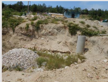
В средней части оползня, на месте снесенных гаражей вырыт котлован. Видны обломки старой подпорной стены.
