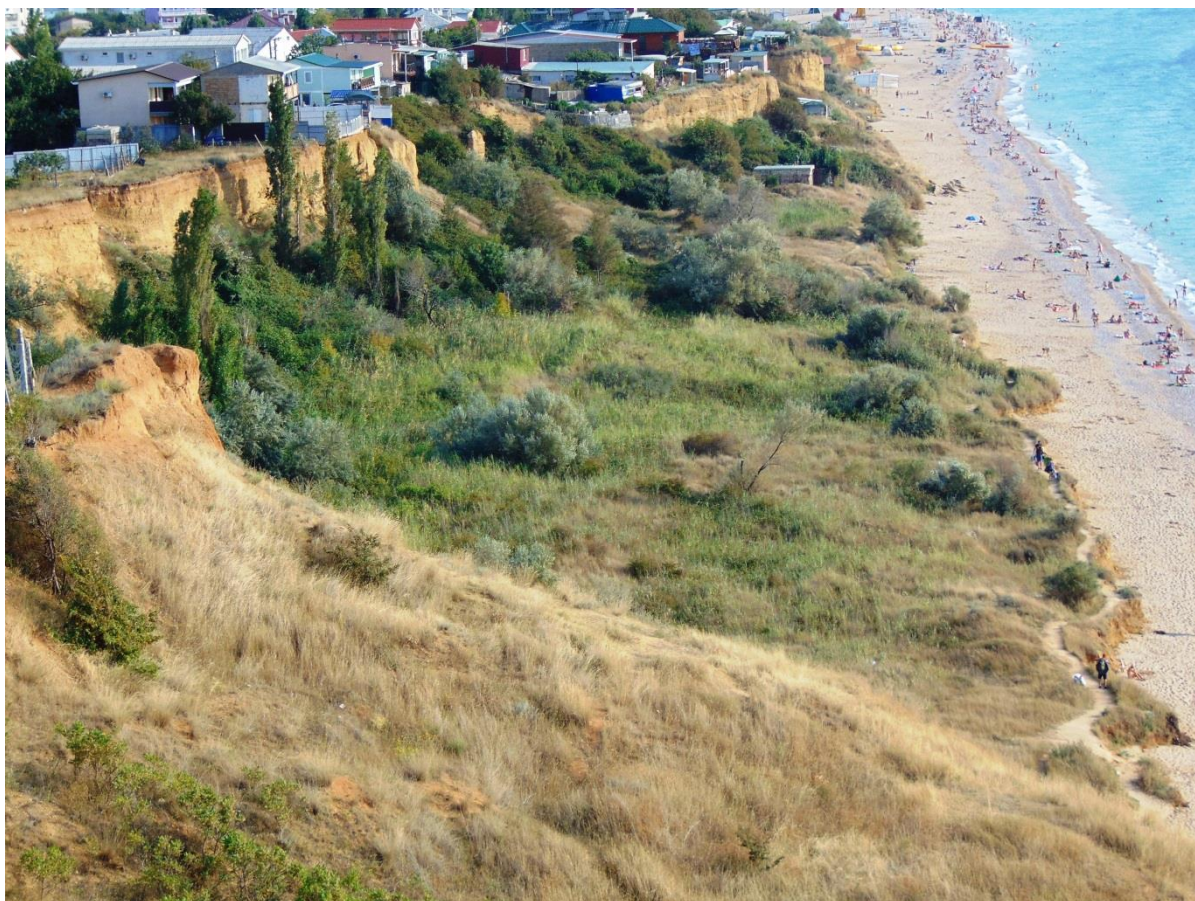
Рис. 2.2.16 Общий вид оползня от правого борта. Поверхность оползня полностью задернована, зарастает кустарником и деревьями III квартал 2019 г. (№ 67-1110-0008)
