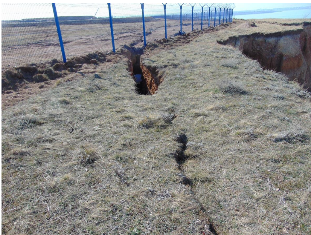
Рис. 2.2.13 Закол блока I-го порядка, южнее приводной станции. I квартал 2019 г. (№ 67-1110-0006)
