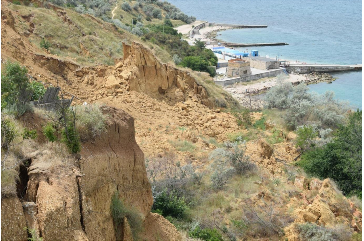
Рис. 2.2.18 Точка наблюдения на бровке головного срыва, у левого борта. Состояние блока I-го порядка, возникшего в начале января 2019 г. Визуально смещения прекратились. III квартал 2019 г. (№ 67-1110-0009)
