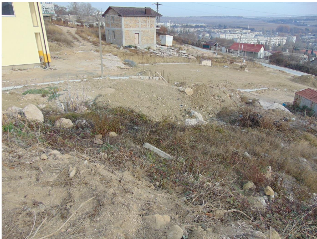
Рис. 2.2.4 Жилые дома построены в пределах оползня «Балаклавский» № 126 у левого борта (№ 67-1110-0002)
