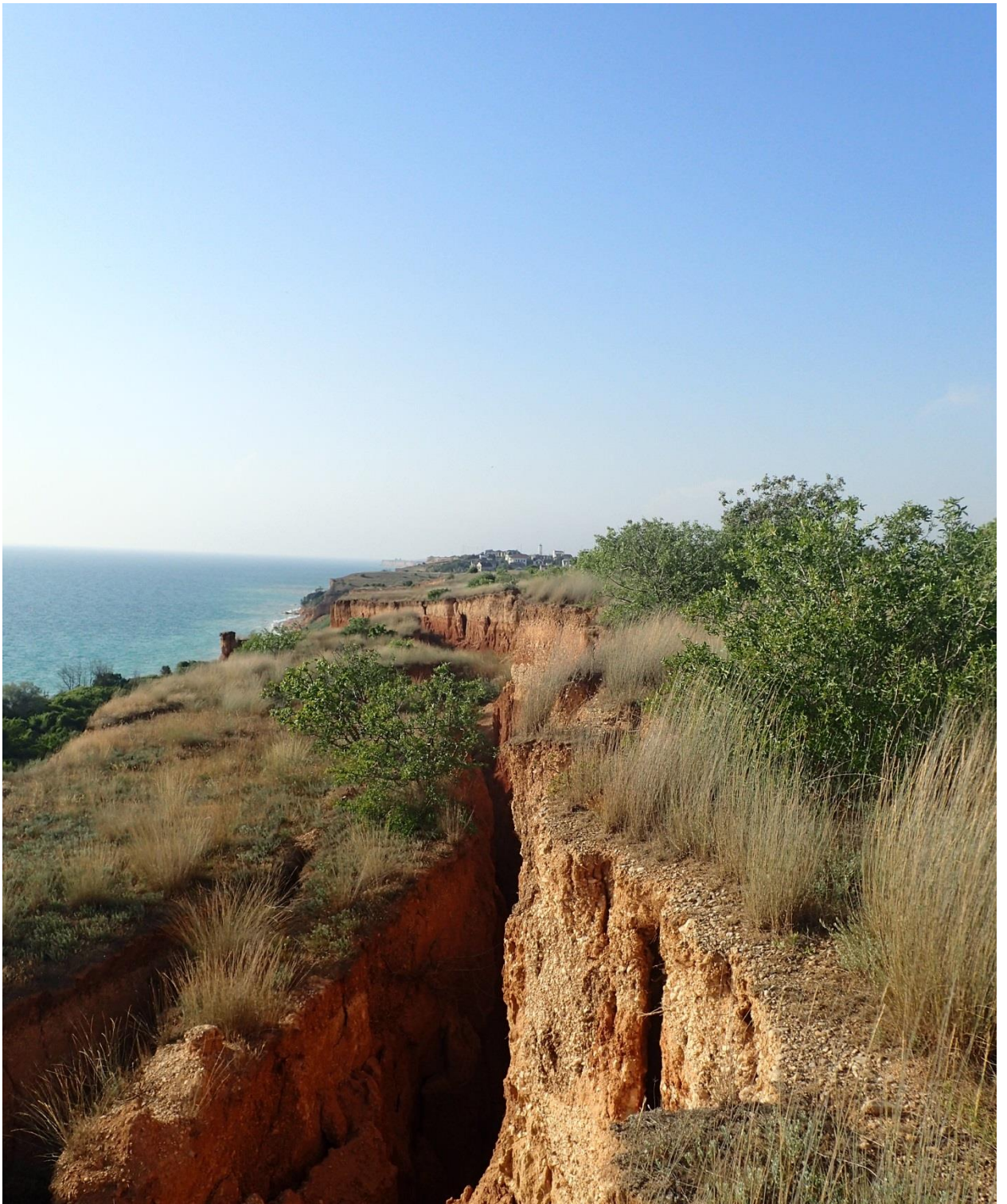
Рис. 2.3.3 Закол блока на бровке головного срыва в северной части оползня № 918 (№ 67-1110-0006)
