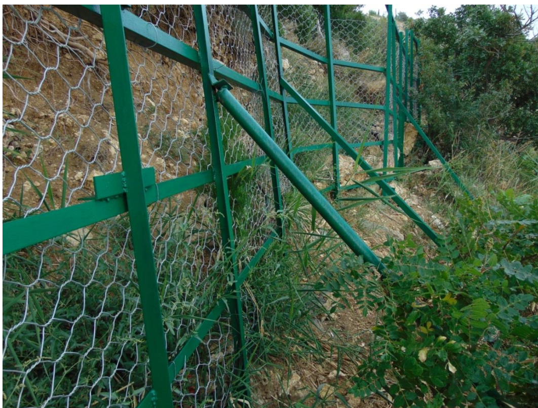
Рис. 2.2.7 На склоне ниже языка оползня установлена камнеулавливающая сетка, которая задержала уже глыбы и грунт (№ 935) (№ 67-1110-0004)
