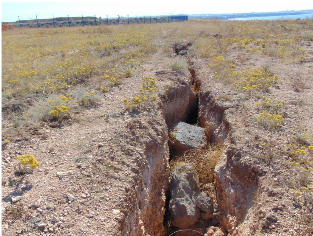
Рис. 2.2.12 Закол блока I-го порядка, южнее приводной станции. IV квартал 2019 г. (№ 67-1110-0006)
