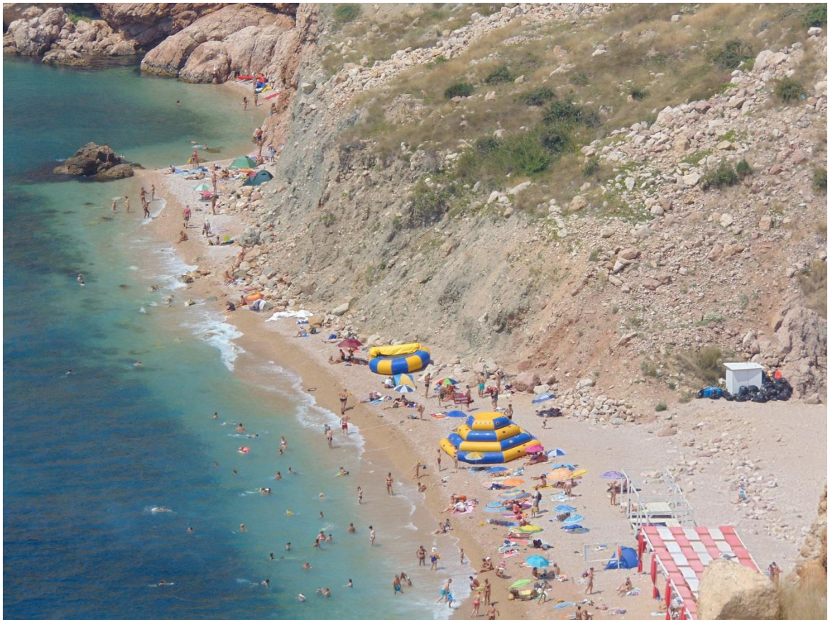
Рис. 2.2.5 Языковая часть оползня. В июне 2019 г. были отмечены два небольших обвала, которые в настоящее время частично размыты. Лестница на пляж в левом борту оползня деформаций не имеет (№ 67-1110-0003)
