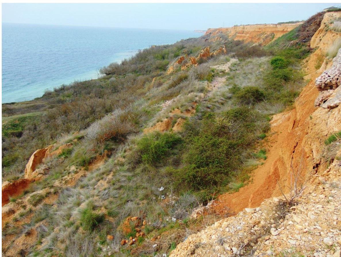
Рис. 2.3.5 Оползень «Балочный» № 915. Правый борт. (№ 67-1110-0005)
