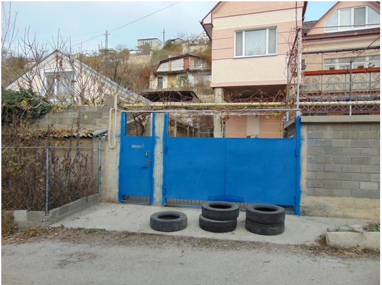
Рис. 2.2.19 Недавно построенный жилой дом в средней части оползня, по улице Подольцева № 27. На строениях деформаций нет (№ 67-1110-00010)
