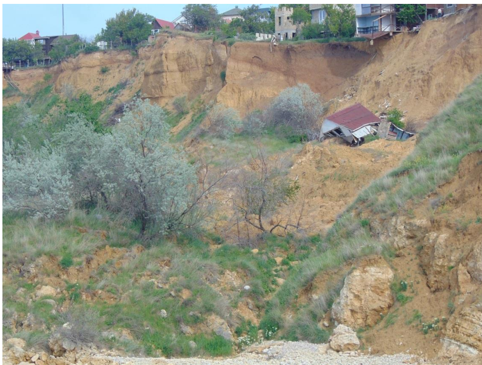
Рис. 2.3.4 «Учкуевский» оползень, август 2019 г. (67-1110-0009)
