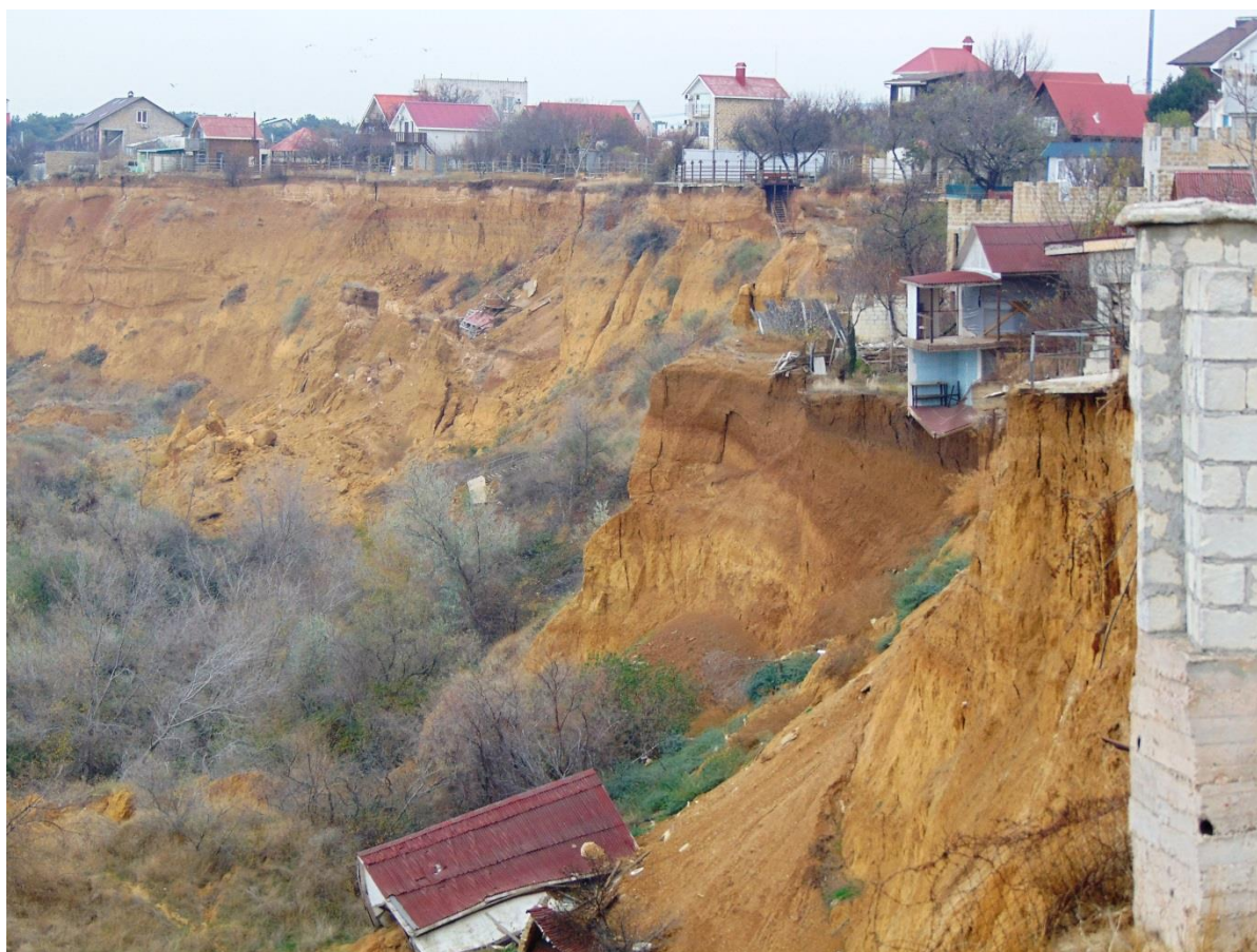
Рис. 2.2.17 Головной срыв и дачи вдоль бровки срыва. IV квартал 2019 г. (№ 67-1110-0009)
