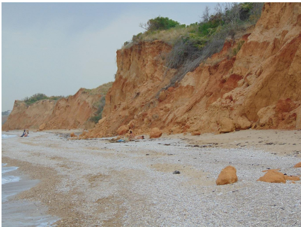
Рис. 2.2.11 На пляже, обвалы в абразионном уступе в языковой части оползня объемами 50-60 м 3 . Ширина пляжа 15-17 м. III квартал 2019 г. (№ 67-1110-0006)
