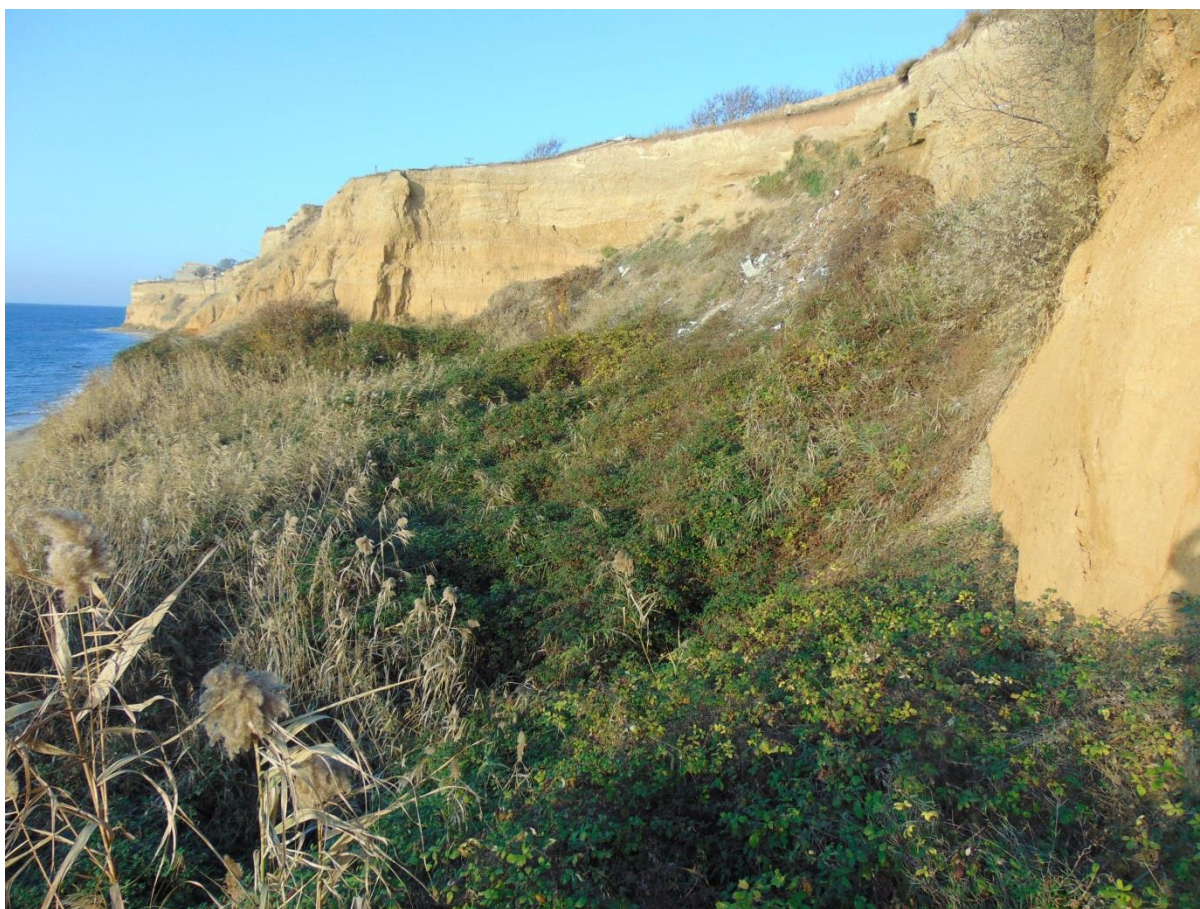
Рис. 2.2.14 Качинский оползень № 919. Поверхность оползня полностью заросла влаголюбивой растительностью (№ 67-1110-0007)
