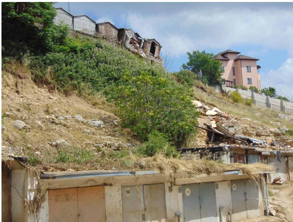
Рис. 2.3.8 Эрозионный размыв склона с выносом грунтов на территорию ГК «Вымпел-2». Июнь 2019 г.
