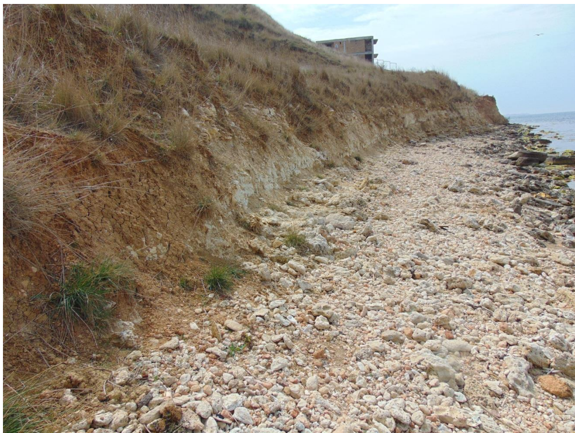
Рис. 2.2.2 На пляже в основании склона за правым бортом оползня № 940. Свежие оплывины на склоне (II квартал 2019 г.) № 67-1110-0001
