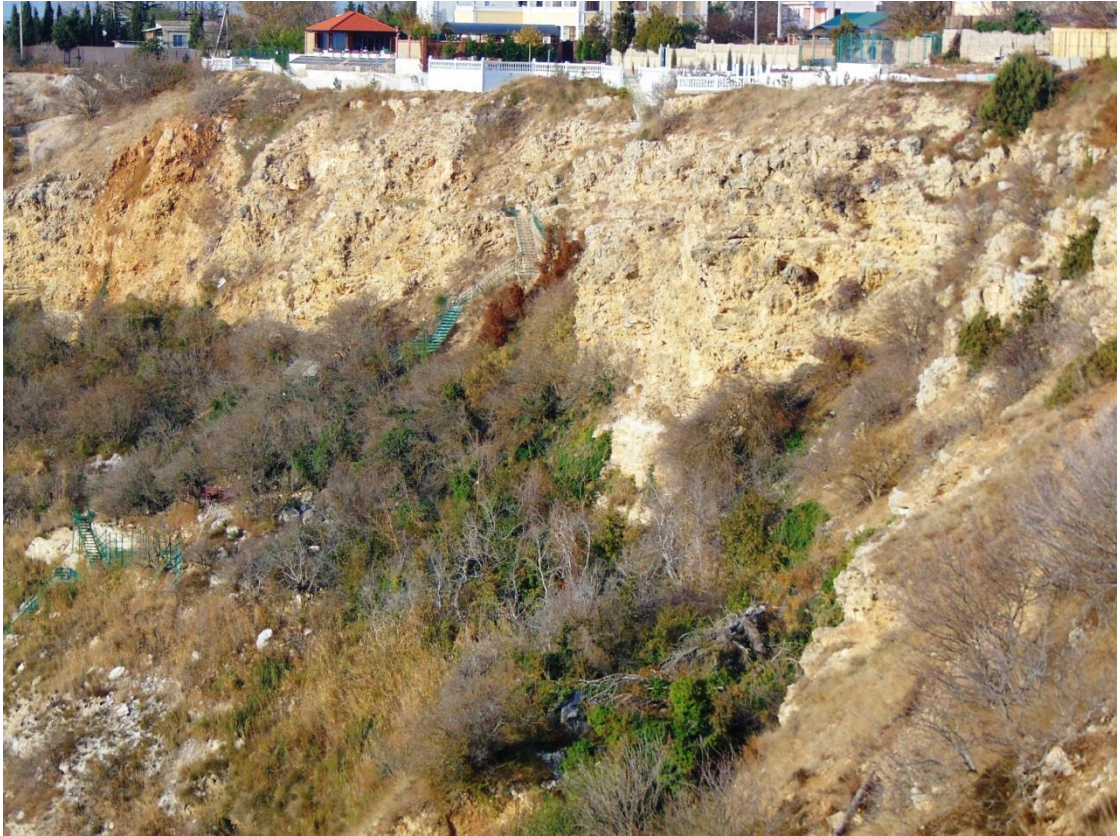
Рис. 2.2.8 Склон с оползнем и металлическая лестница к морю. В верхней части лестница проходит через оползень (№ 67-1110-0004)
