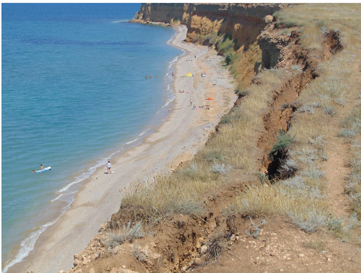
Рис. 2.3.9 Обвалоопасный клиф на протяжении 1,1 км, заколы блоков длиной вдоль бровки до 50 м. «ДТ Кача-Маяк - БО «Атлантус» (ТК «Звёздный берег»)
