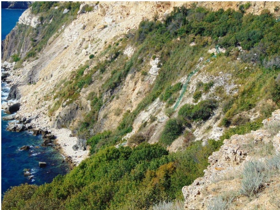
Рис. 2.2.8 Общий вид на оползень «Фиолент-2» №935 (67-1110-0004)
