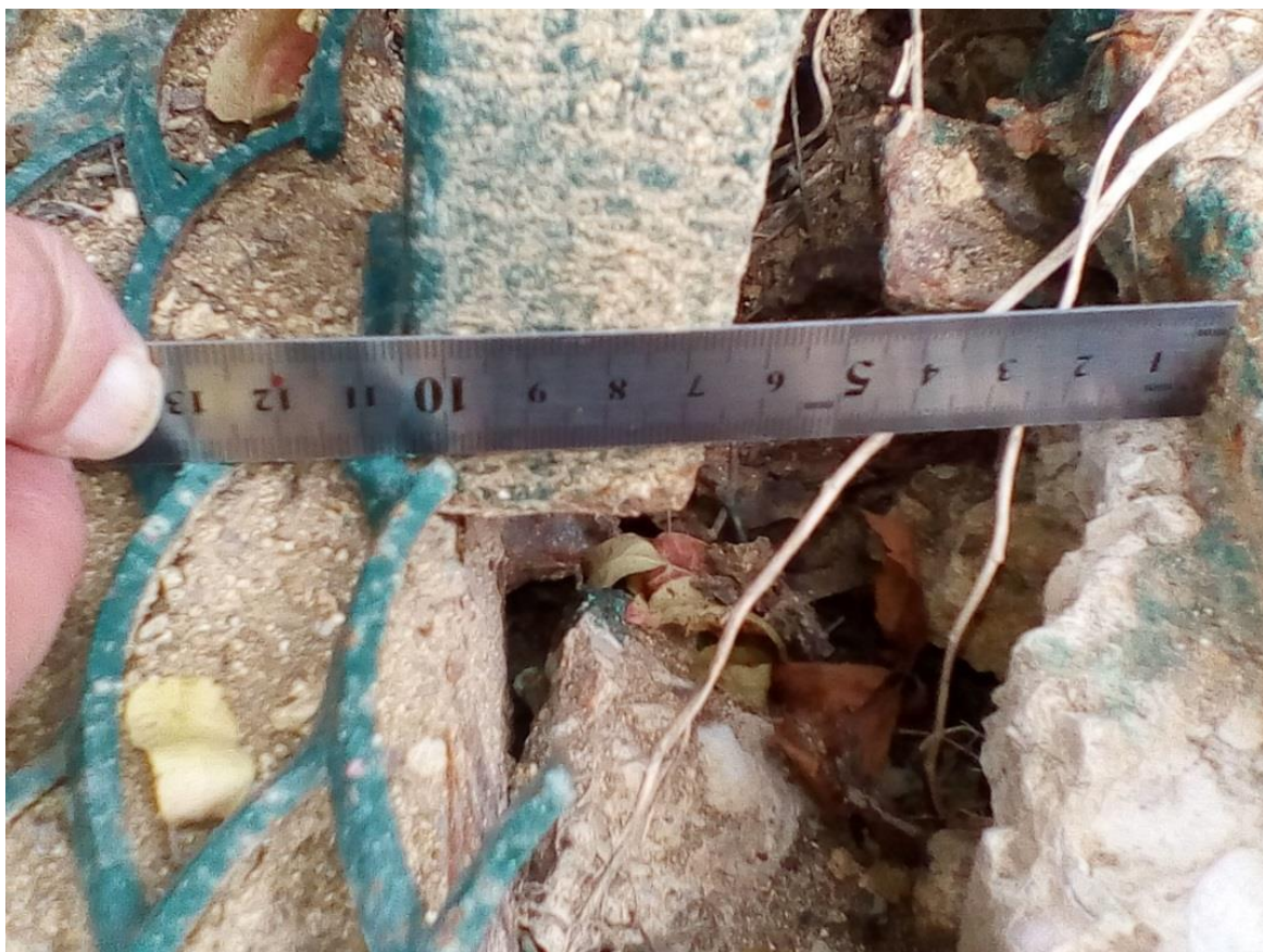
Рис. 2.2.7 Деформация лестницы ниже головного срыва оползня № 935 (67-1110-0004)
