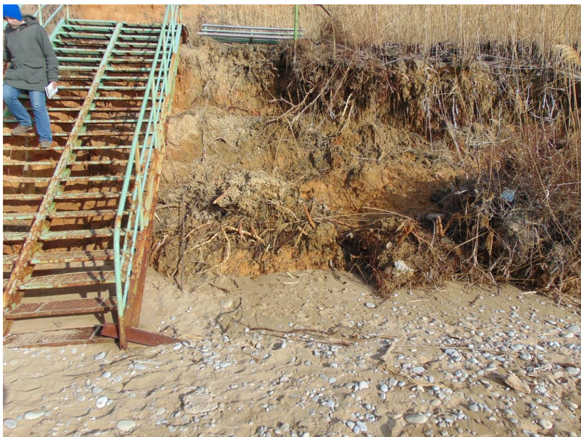
Рис. 2.2.10 Левый борт оползня «Балочный» № 915 (67-1110-0005)
