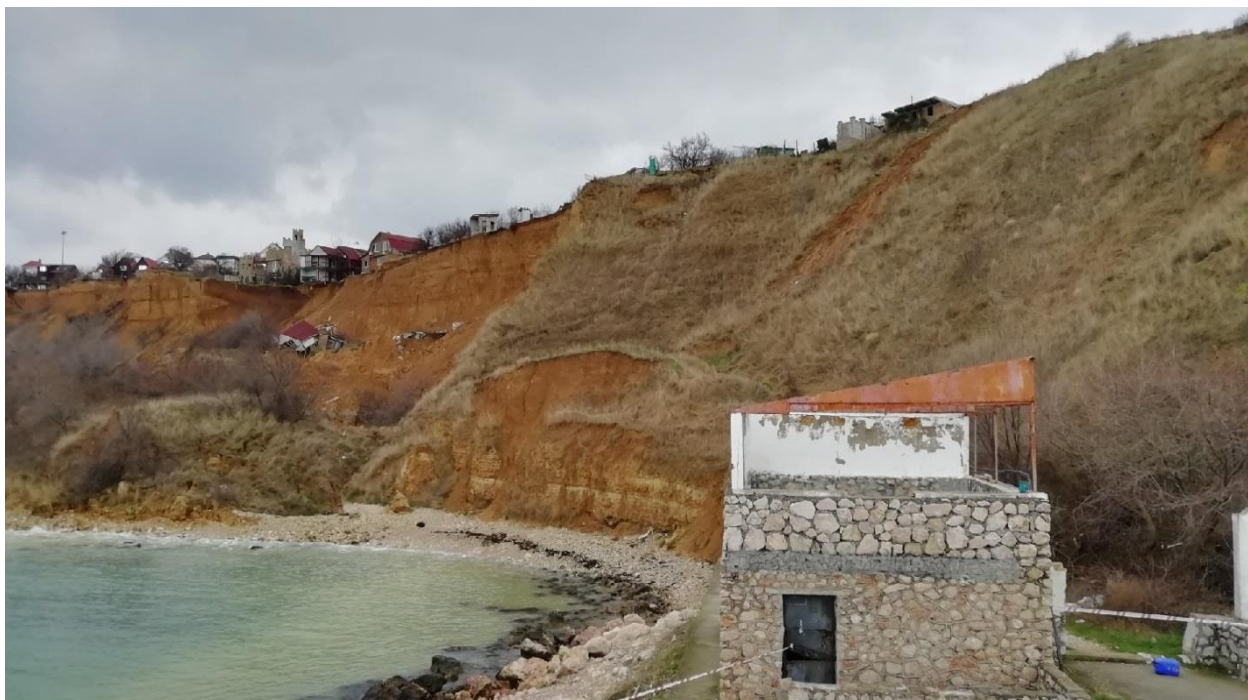
Рис. 2.2.16 Общий вид склона, испытывающего деформации оползневой характера (67-1110-0009)
