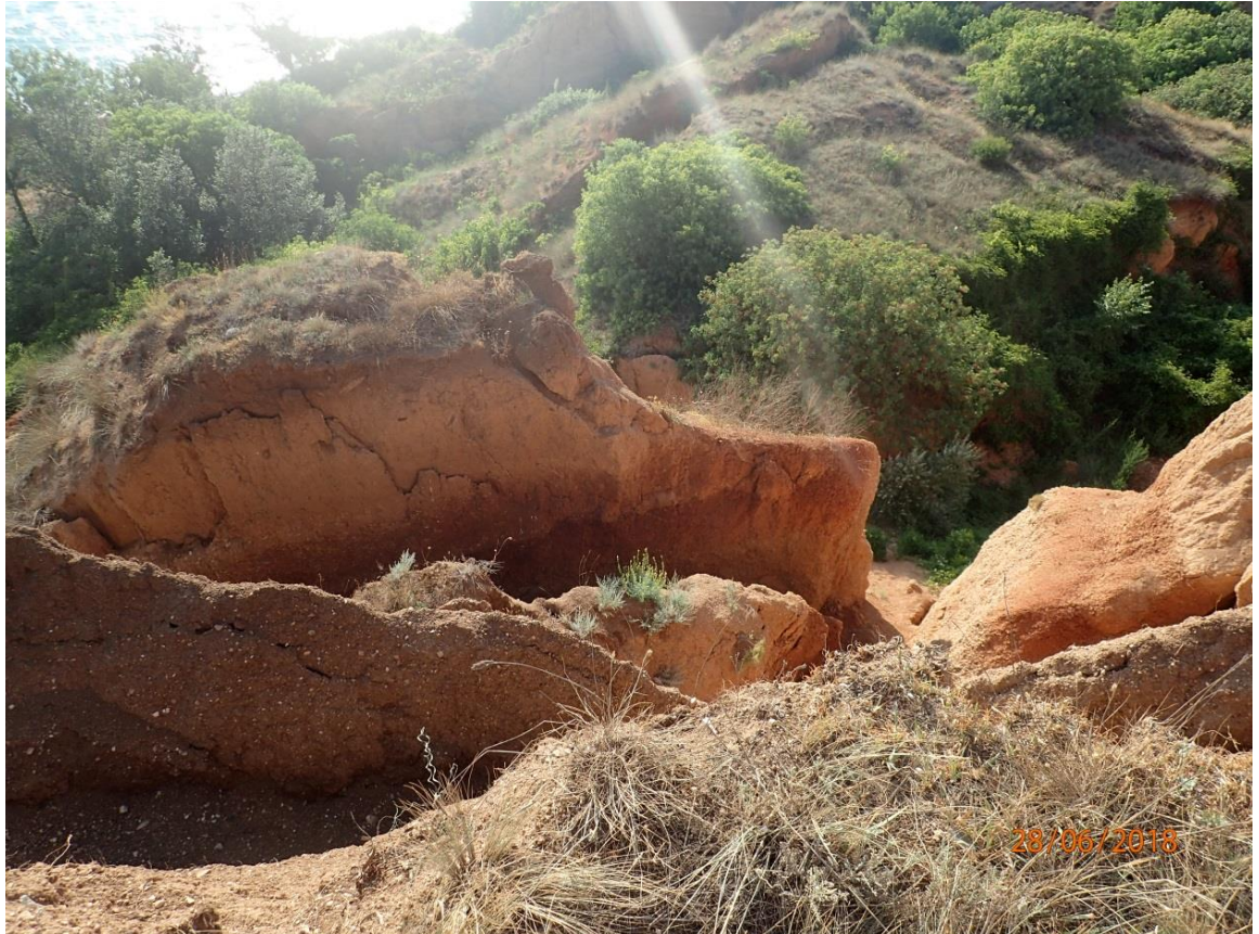
Рис. 2.3.1 На бровке головного срыва оползня № 918 (67-1110-0006)
