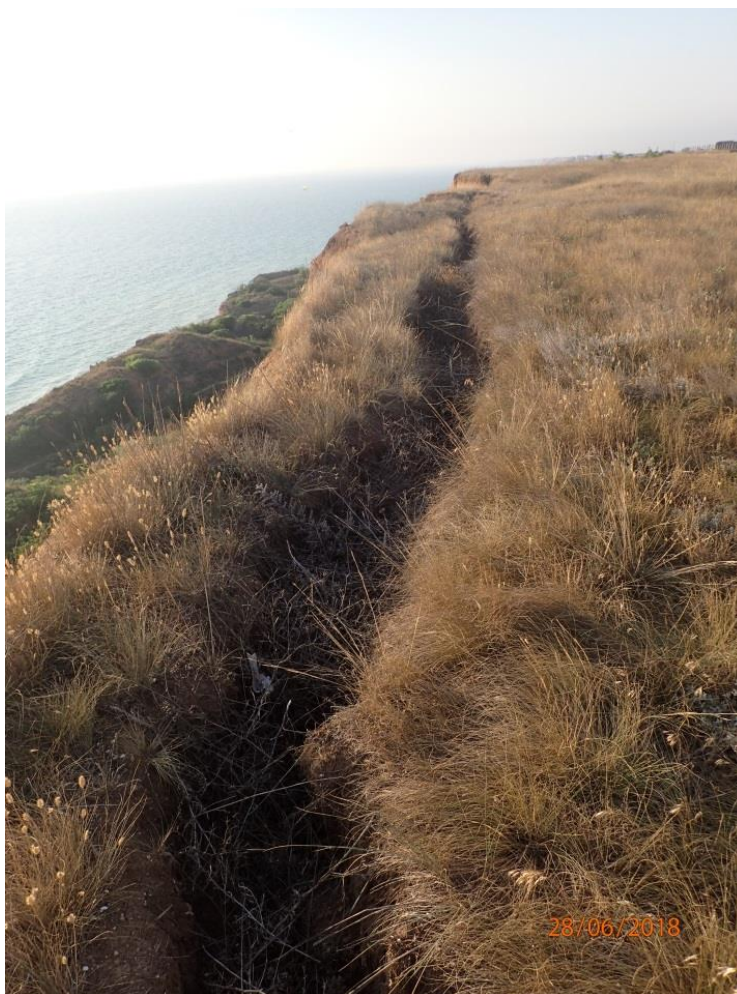
Рис. 2.3.3 Закол блока на бровке головного срыва в северной части оползня № 918 (67-1110-0006)
