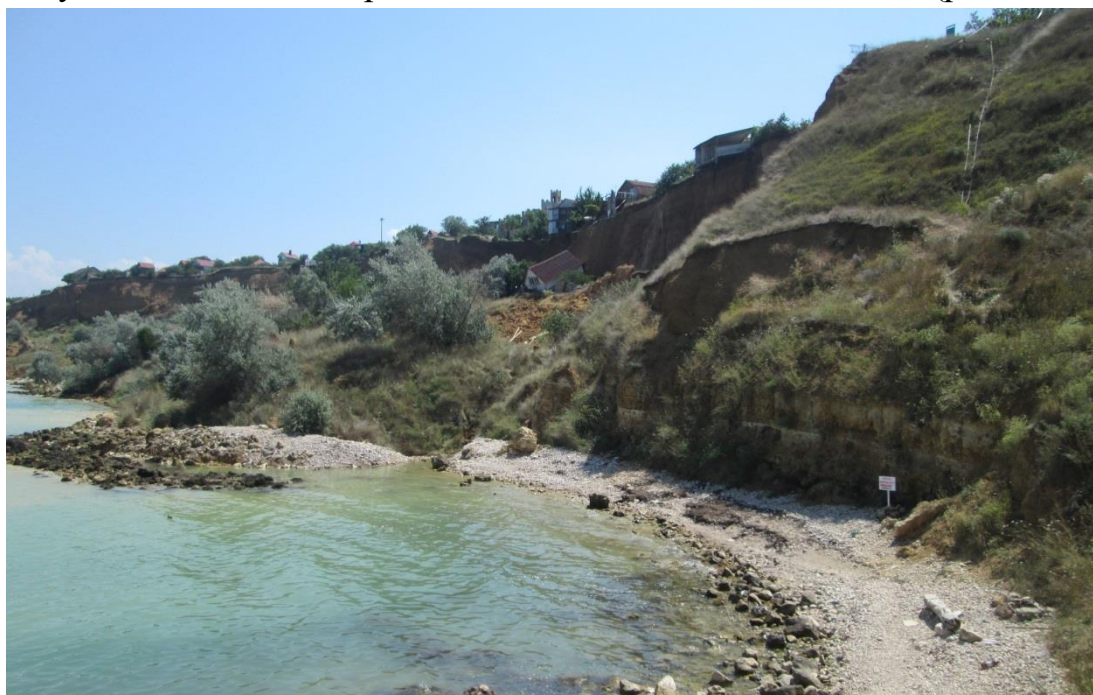
Рис. 2.3.4 «Учкуевский» оползень, август 2018 г. (67-1110-0009)
