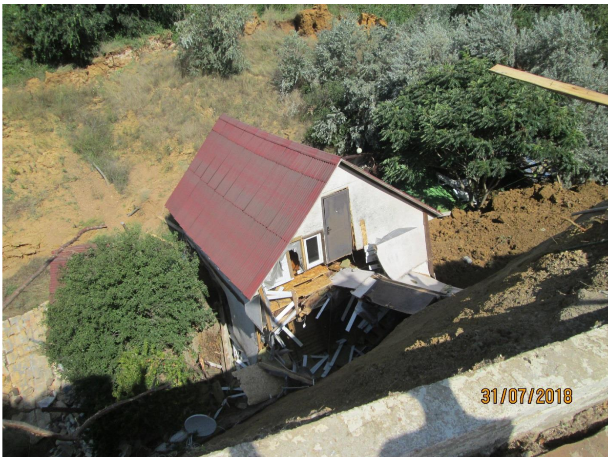
Рис. 2.2.15 Обрушение хозяйственных построек в июле 2018 г. (67-1110-0009)
