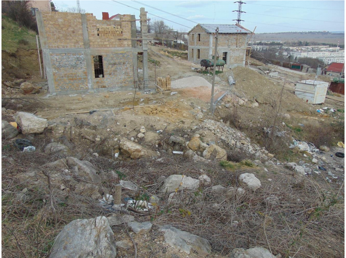
Рис. 2.2.5 Строительство ИЖС в средней части у левого борта Балаклавского оползня № 126 (67-1110-0002)
