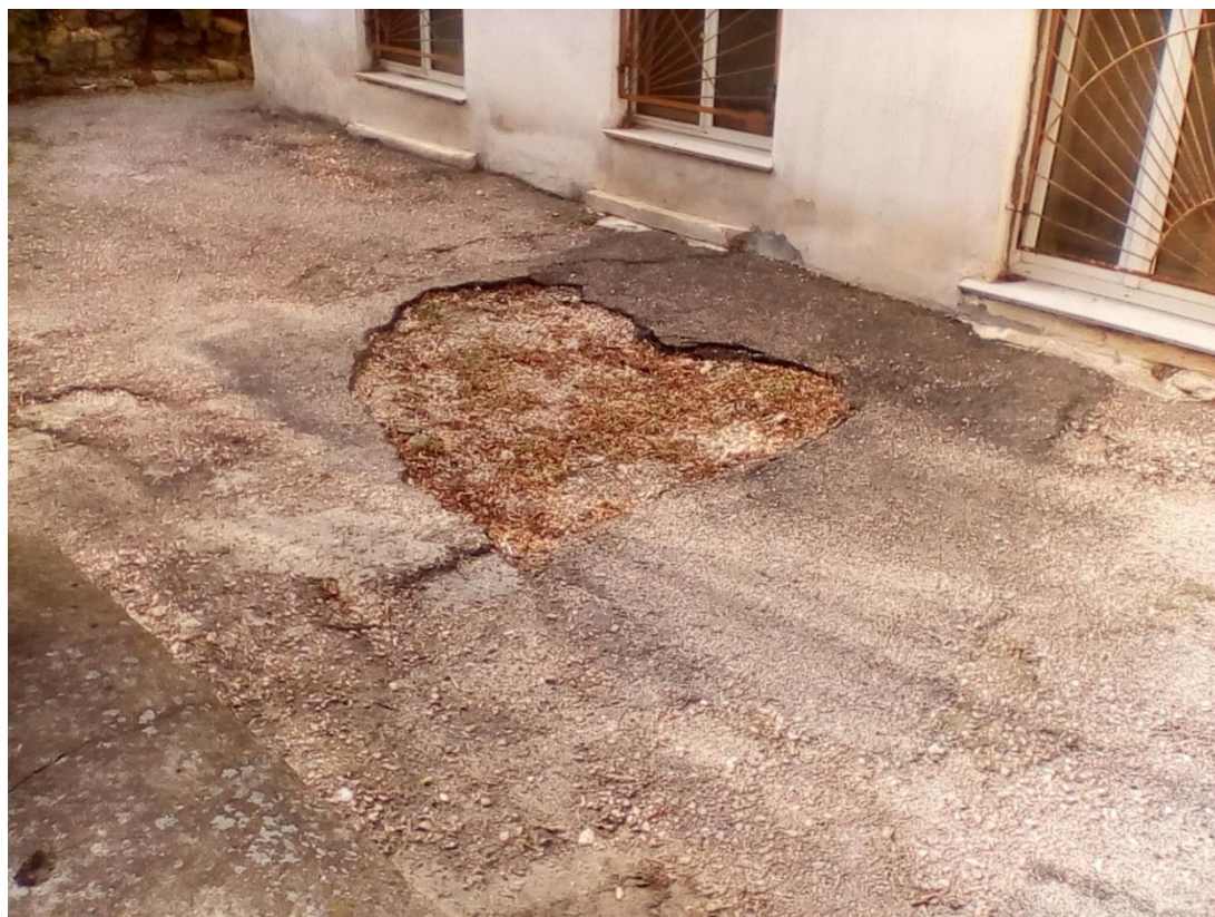
Рис. 2.2.3 Провал в торце дома №11 по ул. Адм. Макарова. (67-1110-0001)
