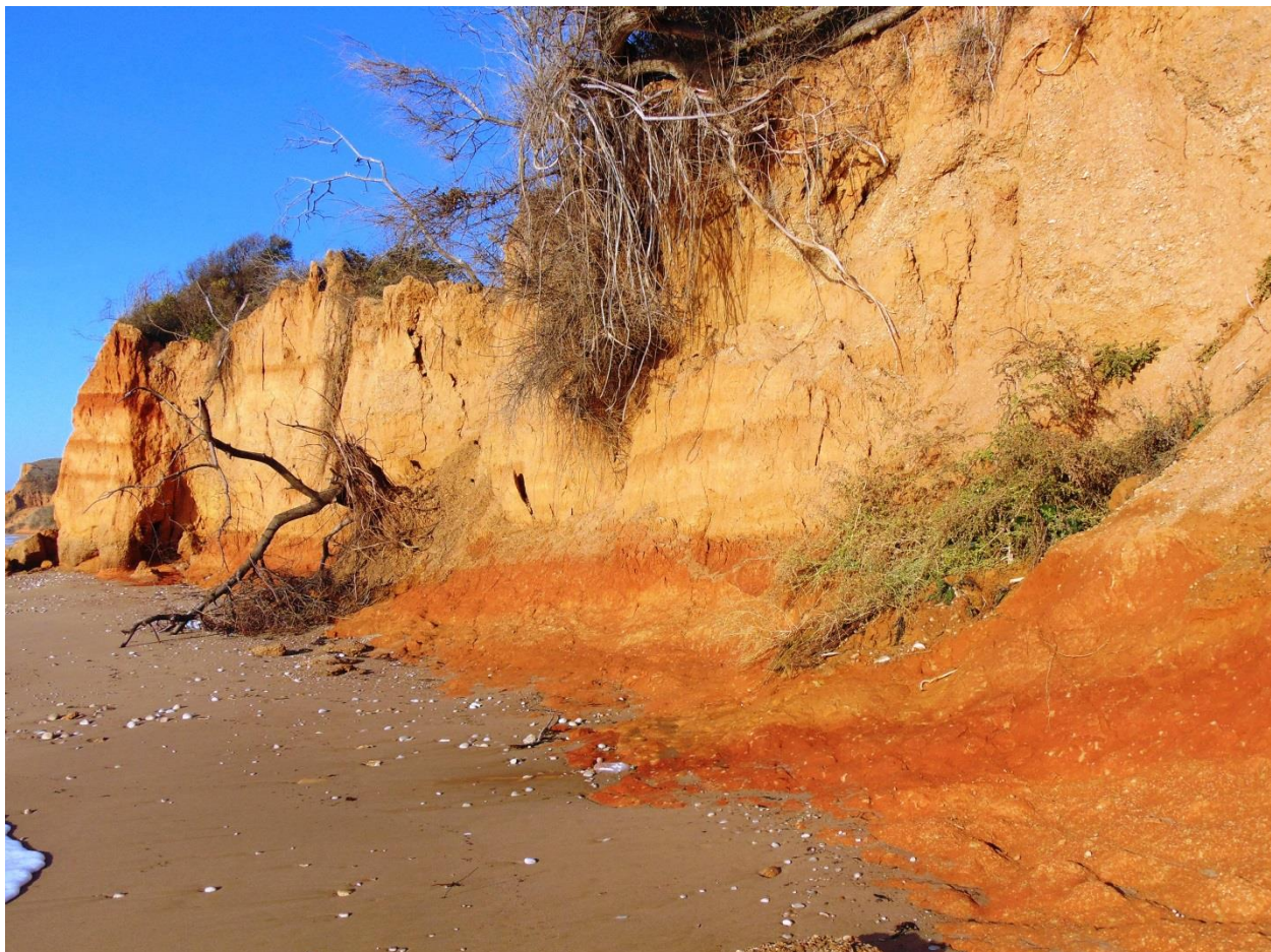
Рис. 2.2.12 Последствия шторма в северной части оползня № 918 в ноябре 2018 г. (67-1110-0006)
