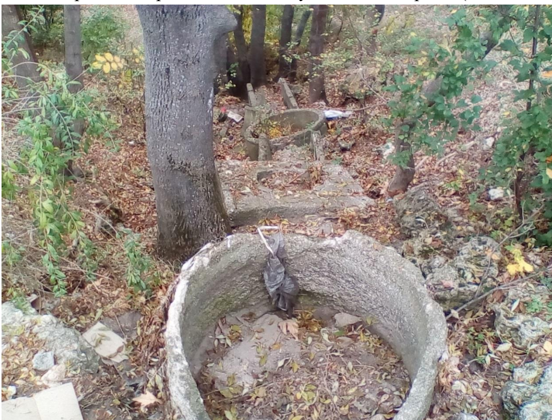
Рис. 2.2.4 Эрозионная промоина и разрушенная система водоотвода на западном склоне Ушаковой балки (67-1110-0001)
