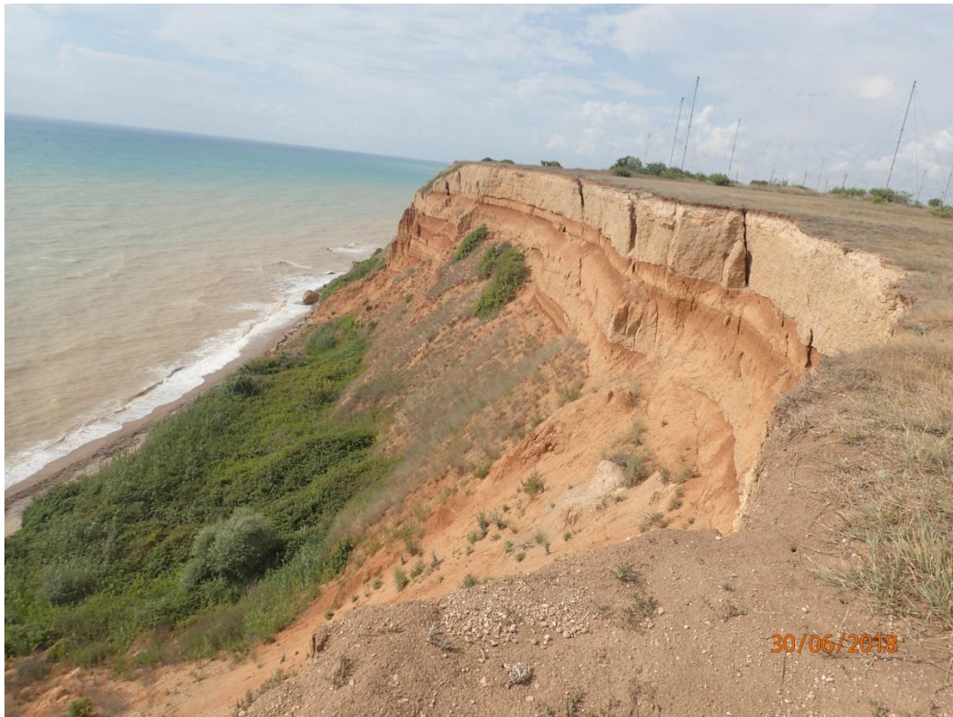
Рис. 2.3.5 Оползень «Балочный» № 915. Правый борт (67-1110-0005)
