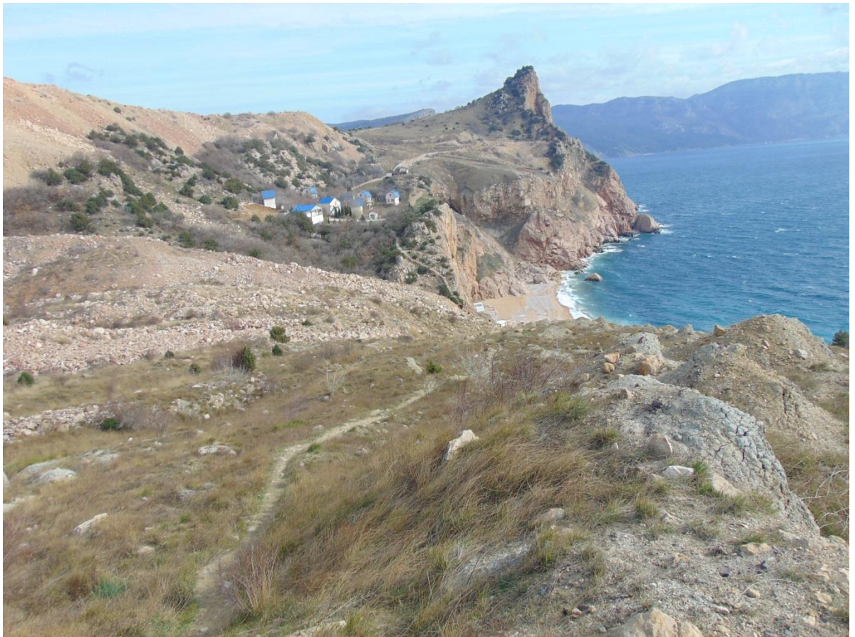
Рис. 2.2.6 Языковая часть «Василевского» оползня. Глыбовый навал (67-1110-0003)
